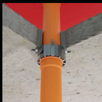
MONTAŻ KOŁNIERZA NA MUFIE RURY PALNEJ
