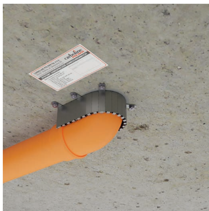
MONTAŻ KOŁNIERZY CARBOCOLLAR W KSZTAŁCIE U NA KOLANIE RURY PVC.
