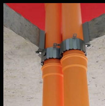
KOŁNIERZE NA RURACH PROWADZONYCH BLISKO SIEBIE
