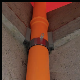
MONTAŻ KOŁNIERZA NA RURZE W NAROŻNIKU POMIESZCZEŃ
