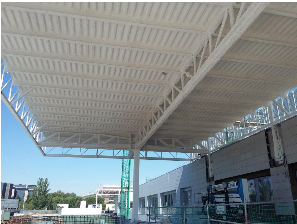
Zdjęcie 1 (Zaprawa natryskowa w magazynie przemysłowym)
