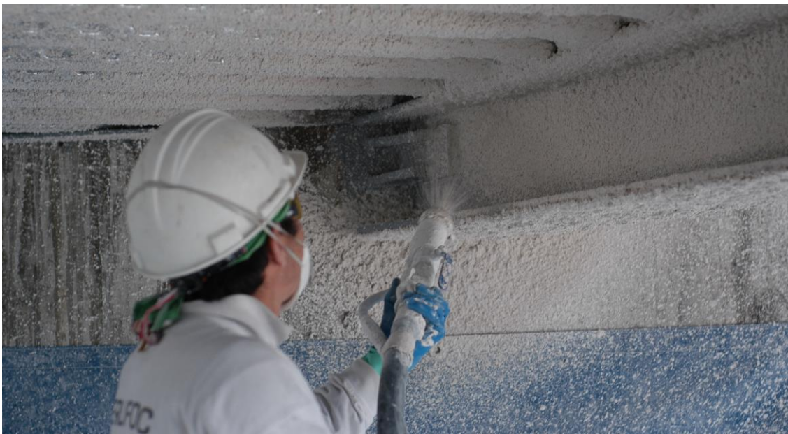
Zdjęcie 10 (Szczegóły nakładania zaprawy)
