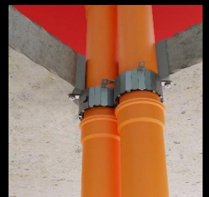
KOŁNIERZE NA RURACH PROWADZONYCH BLISKO SIEBIE
