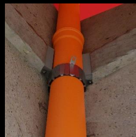
MONTAŻ KOŁNIERZA NA RURZE W NAROZNIKU POMIESZCZEN
